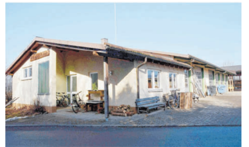
Der Engstinger Bauhof wird um ein kleines Bürozimmer erweitert, das im Eingangswindfang entstehen soll. Foto: Reiner Frenz
